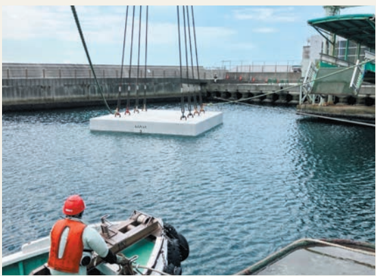
据え付け位置の調整中
