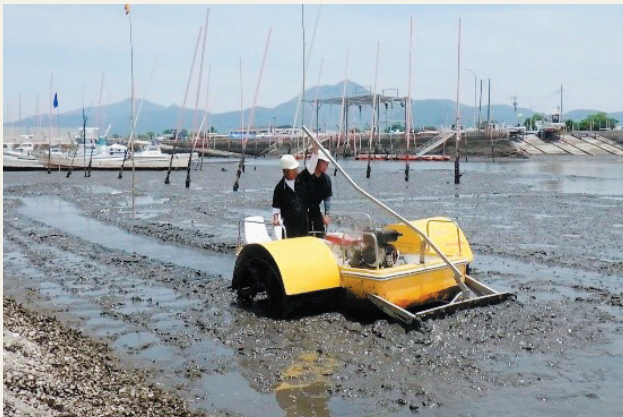
干潟走行機による排土
