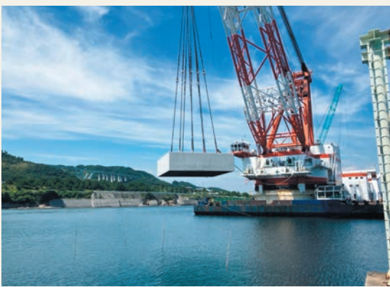
コンクリートブロック据付状況
