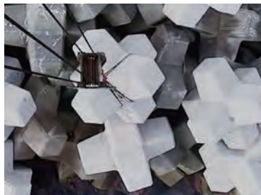
AIカメラを使用し据付位置を確認しながらピンポイントに据付
