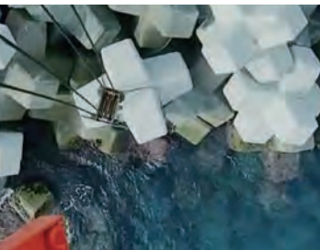
AIカメラを使用し据付位置を確認しながらピンポイントに据付
