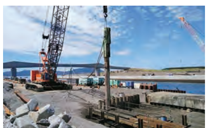
担当技術者とオペレーターは、モニターで鋼管矢板の位置情報を共有し、連携して打設管理を行う
