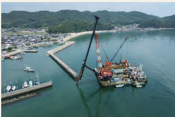
鋼管杭の打設状況
