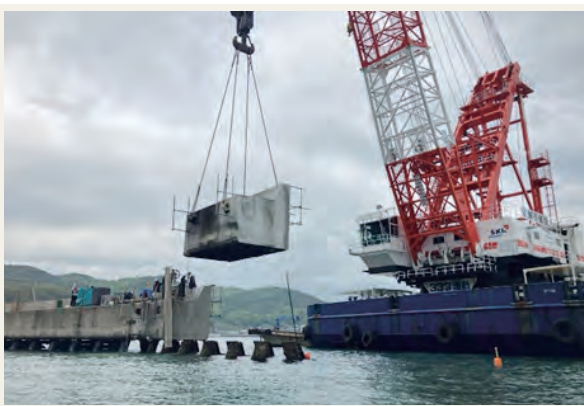
起重機船による上部工撤去
