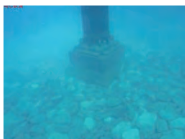
捨石均し状況
