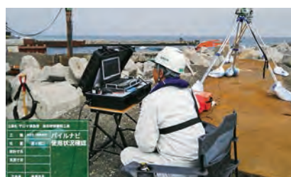
担当技術者とオペレーターは、モニターで鋼管矢板の位置情報を共有し、連携して打設管理を行う
