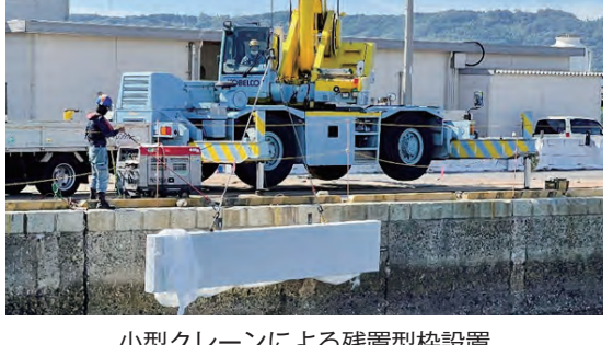
小型クレーンによる残置型枠設置
