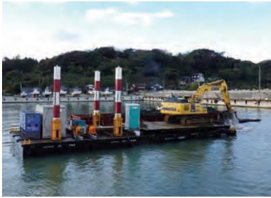
3Dマシンコントロールバックホウによる浚渫
