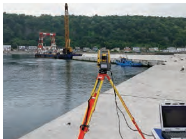
トータルステーション設置
