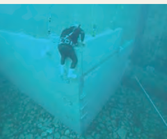
残置型枠設置状況
