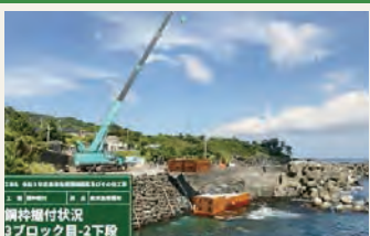
鋼製型枠の据付
