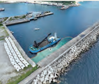
捨石投入(汚濁防止膜設置)
