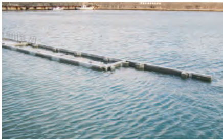
狼煙漁港における残置型枠による施工
