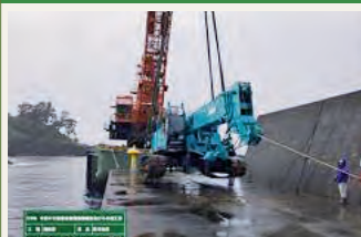
75t吊テレスコピッククレーンの搬入
