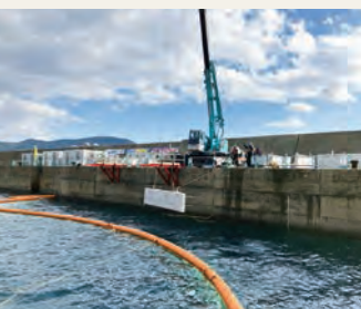
残置型枠設置状況
