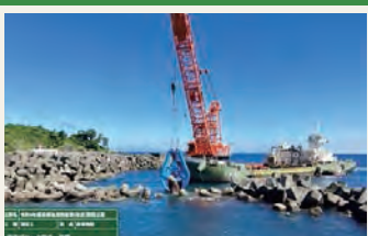
消波ブロックの撤去(三本爪バケット使用)
