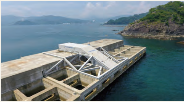
環境省事業による防波堤搭載型波力発電装置
