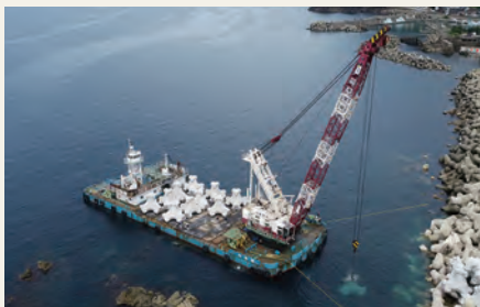
300t吊起重機船「関動丸（かんだうまる）」
