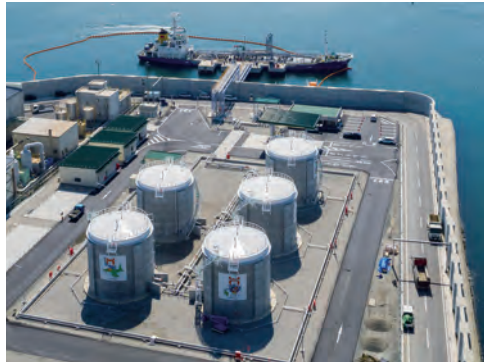
気仙沼油槽所/津波対応型PC燃油タンク
