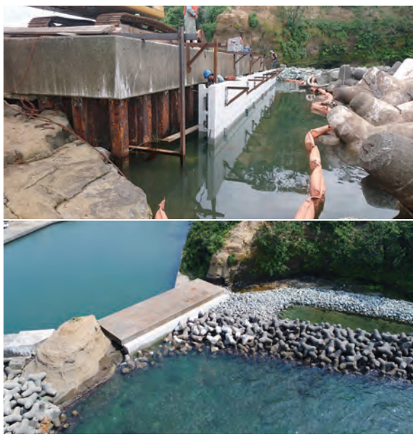
石川県 橋立漁港における防波堤への腹付工の事例
