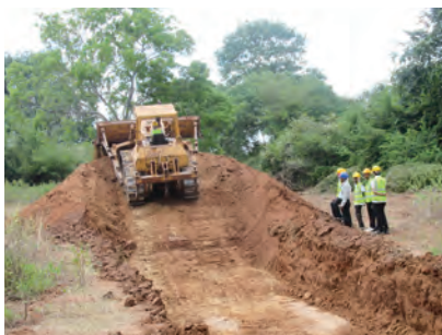
ブルドーザーのオペレータ訓練風景
