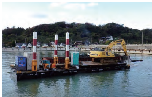
写真：浚渫工事の様子
