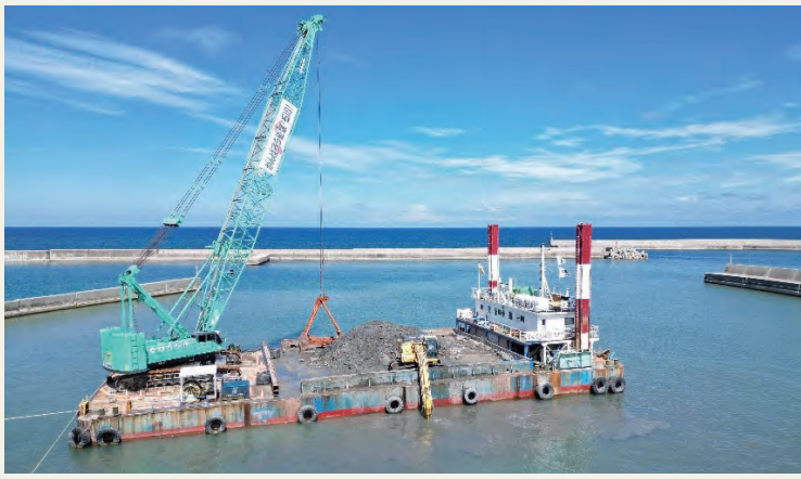
狼煙漁港内を浚渫する「第八北斗号」
