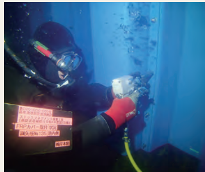
高串漁港県営漁港施設ストックマネジメント事業工事
