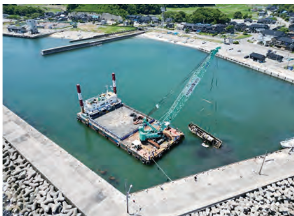
漁船引き揚げ作業状況
