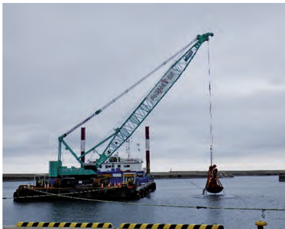
-4.5m 泊地浚渫作業状況
