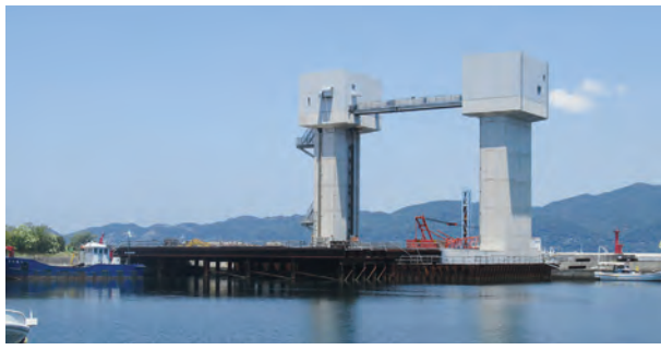
整備中の津波に対する「港口水門」
