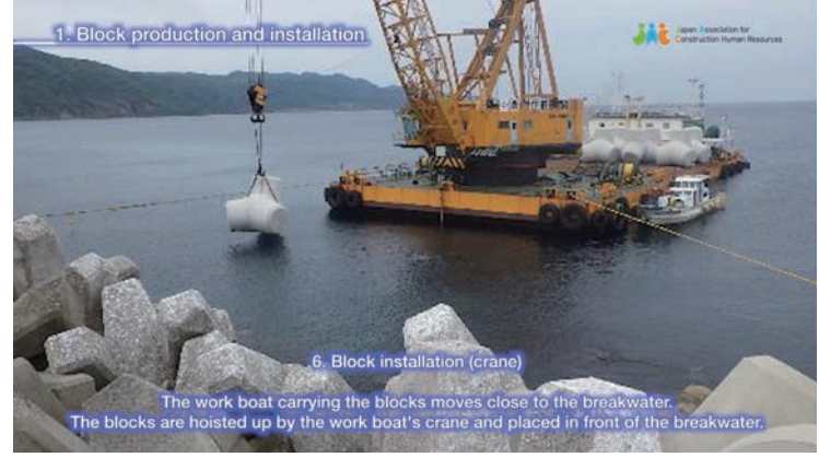
消波ブロック設置の場面
