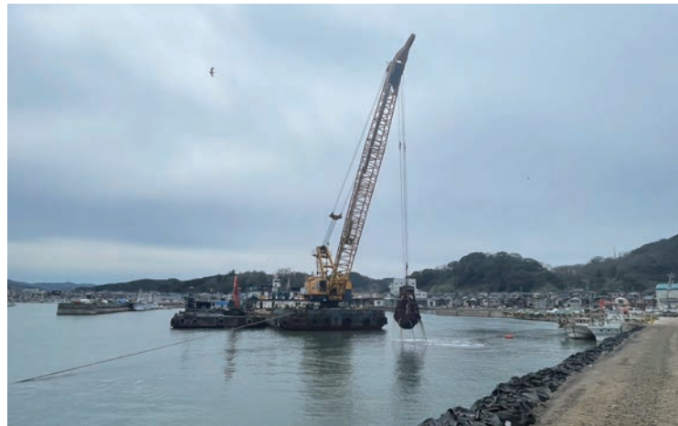
会員企業による漁船だまり浚渫作業 (輪島港)
