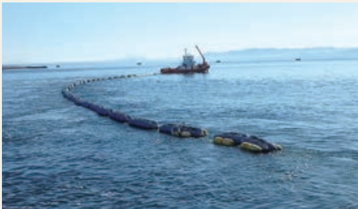
アイスブームの設置作業状況
