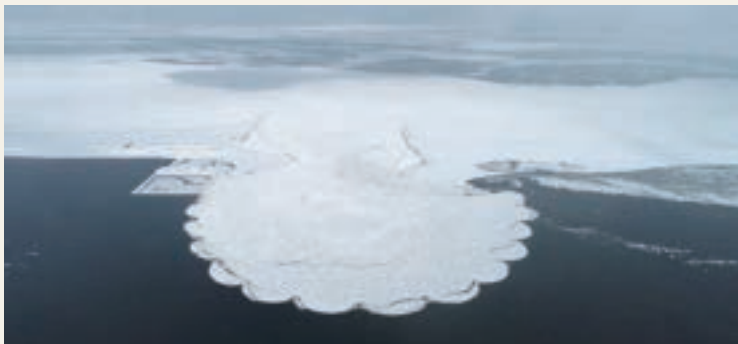
サロマ湖内に流入する流水を制御するアイスブーム (第1湖口)
