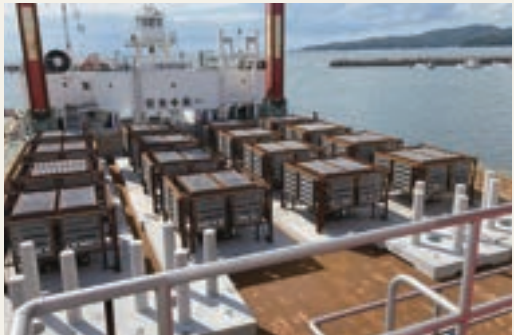
起重機船積荷状況
