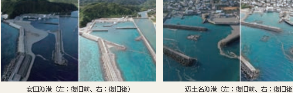
安田漁港（左：復旧前、右：復旧後）
