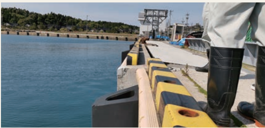
蛸島漁港の被害状況
